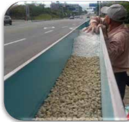
난간화분에 퍼라이트, 화산석 및 영양토 포설작업
